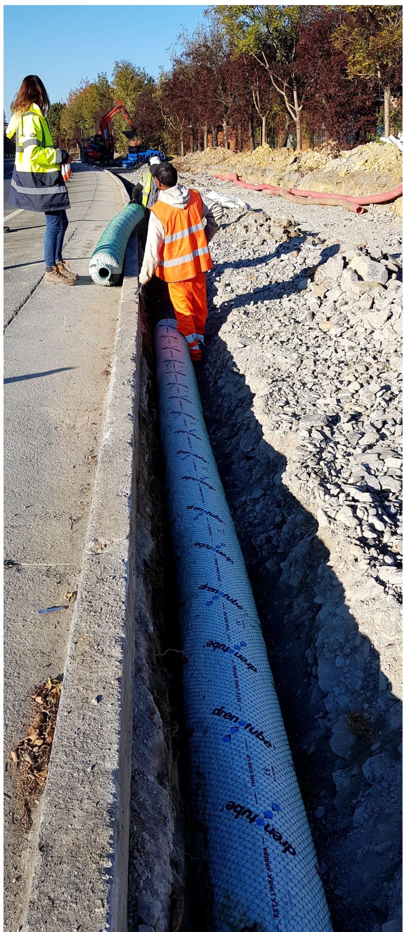
Travaux public — Hondarribia, Gipuzcoa
