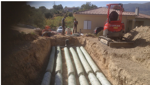
Micro station complémenté par le système drenotube® - Colomars, France
