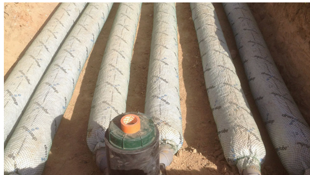
Micro station complémenté par le système drenotube® - Colomars, France
