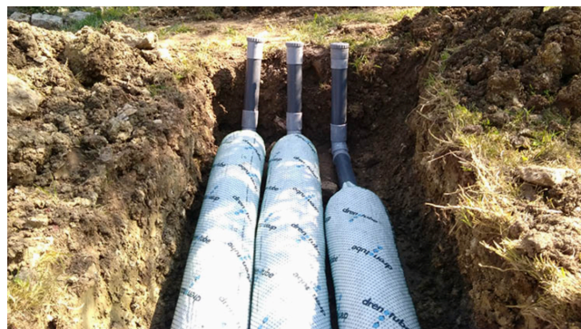
Usine de traitement des eaux usées installée à Opio, France
