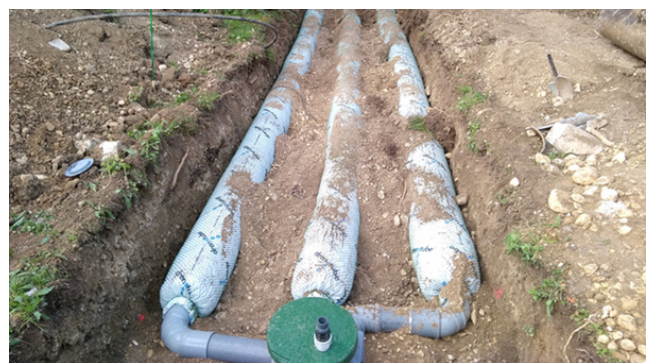
Instalación de microestación con sistema drenotube® - Niza, Francia
