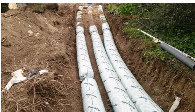
Instalación de microestación con sistema drenotube® - Niza, Francia
