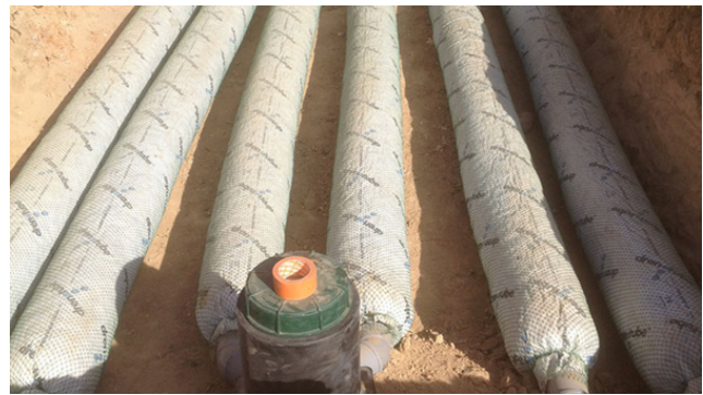
Microestación complementada con sistema drenotube® - Colomars, Francia
