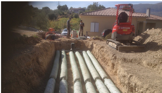
Microestación complementada con sistema drenotube® - Colomars, Francia
